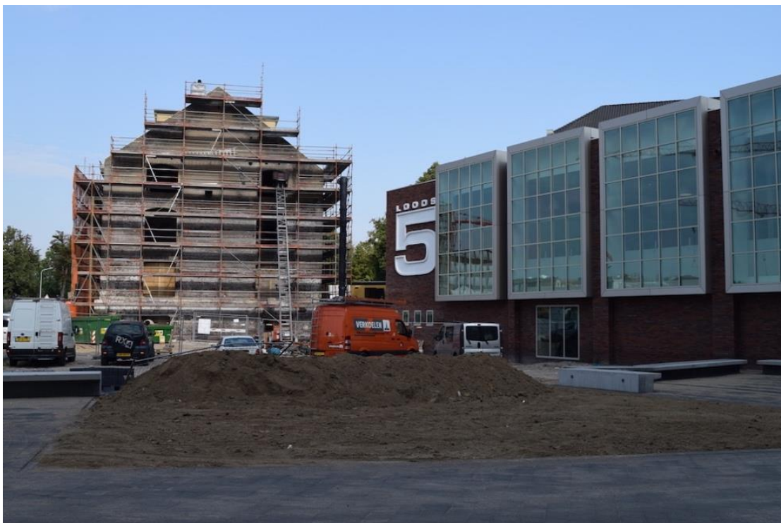
Vorbereiding aanleg P. Regoutplein
