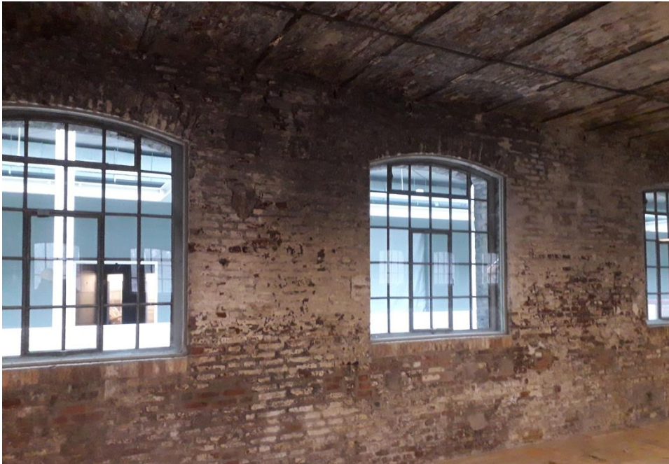
Gietijzeren kozijnen met voorzetglas
