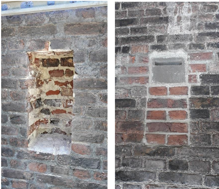
Nis gemaakt voor plaatsing vleermuiskast
